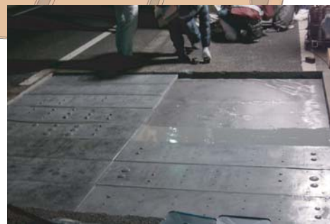
実橋 敷設試験
