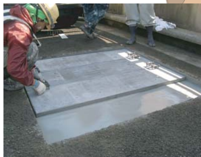
事前敷設試験
