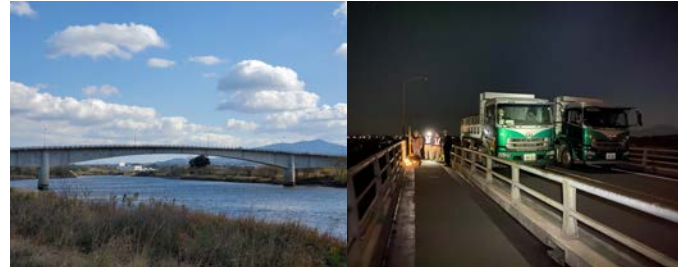
図2 対象橋梁全景および載荷試験
