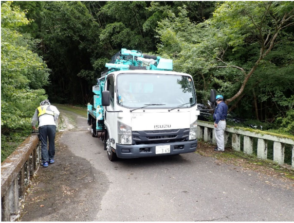
写真-3 たわみ計測状況 (80kN 荷重車)
