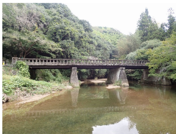
写真-1 束荷橋側面状況
